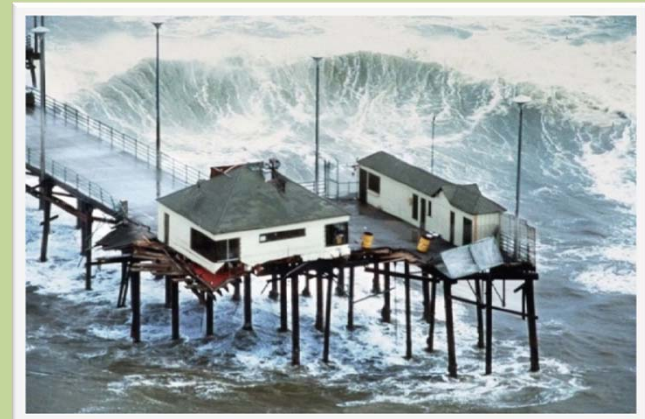
Muelle de Huntington Beach Pier - Daños por El Niño de 1983 Fuente : OC Register
