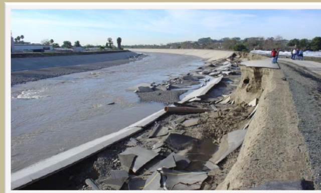
Arroyo San Juan - Los daños causados por la tormenta de 2005 Fuente: Condado de Orange
